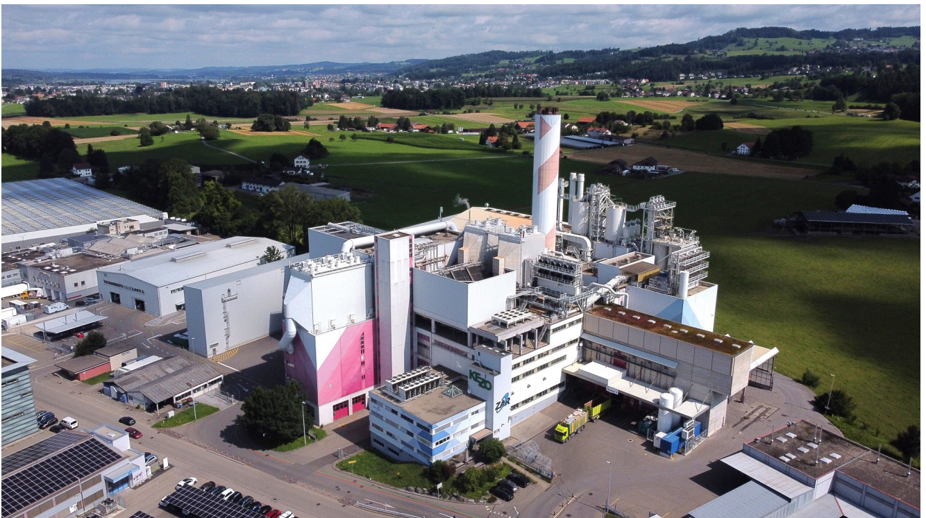
Bestehende KVA in Hinwil (Quelle: KEZO)
